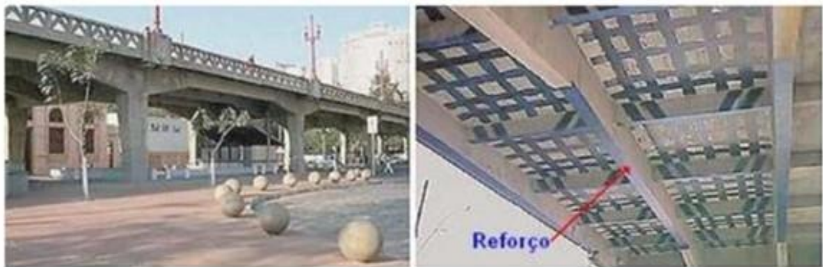
Figura 16 - Reforço em fibras de carbono.
