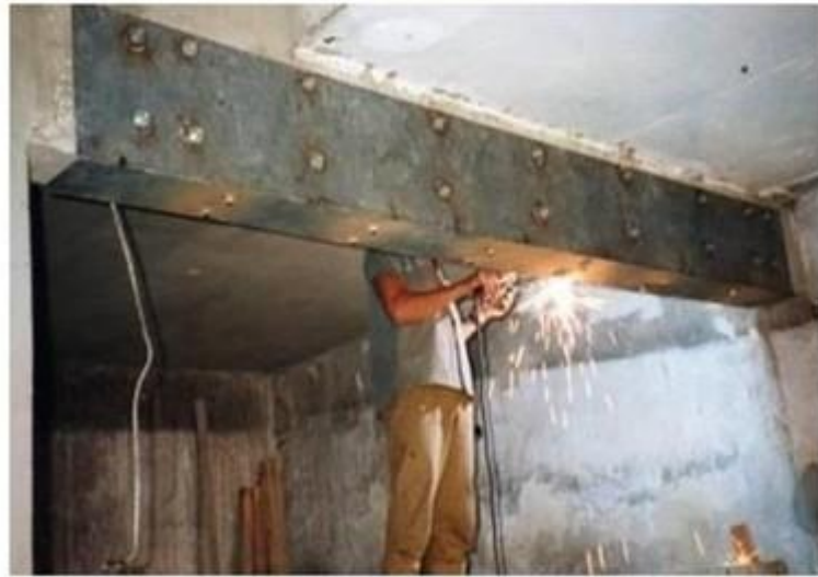
Figura 12 - Reforço com chapas de aço colada.
