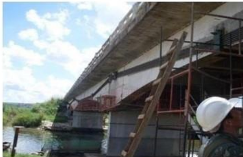
Figura 13 - Figura de viga com pretensão externa.
