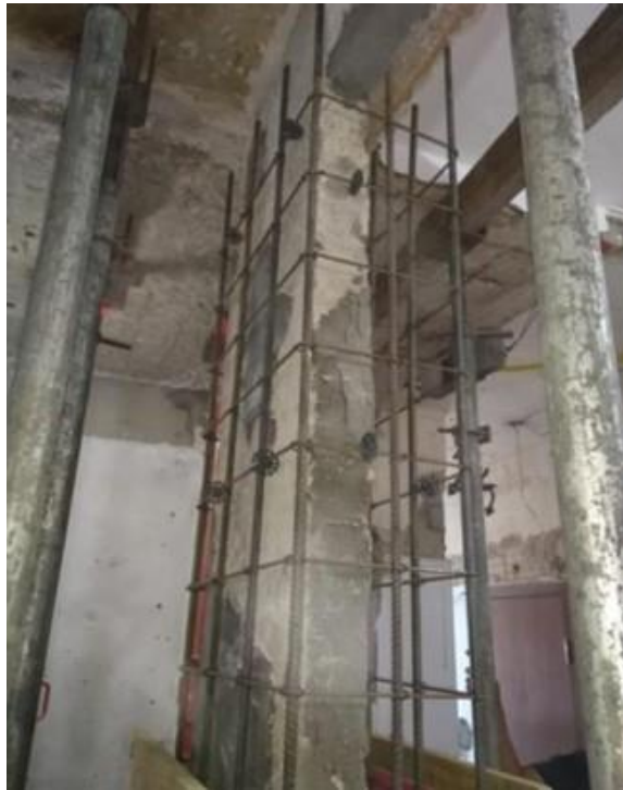
Figura 10 - Posicionamento da armadura.
