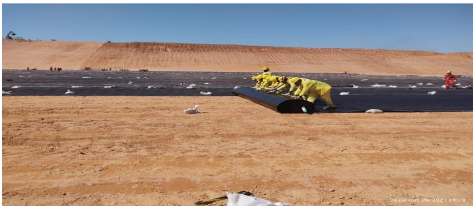
Figura 4: Lançamento de geomembrana no fundo reservatório
