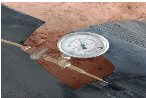
Figura 12: Ensaio de pressurização com monômetro
