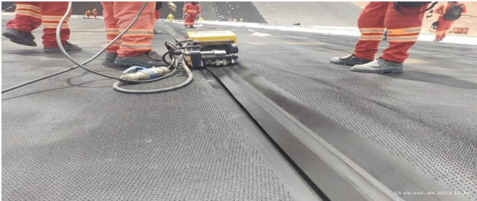
Figura 6: Solda por Termofusão, empresa TDM Brasil
