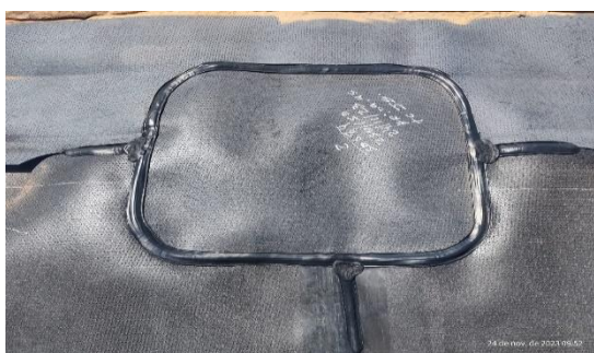
Figura 10: Reparo a extrusão
