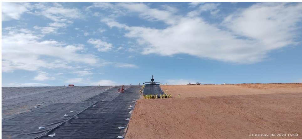
Figura 5: Lançamento de geomembrana em talude
