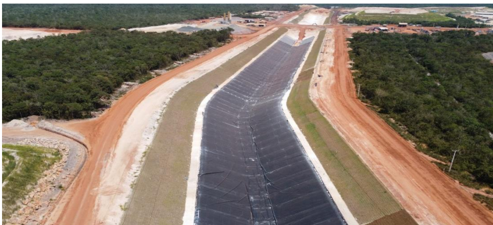
Figura 3: Canal para transferência de água
