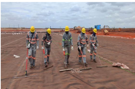
Figura 14: Spark test em painéis
