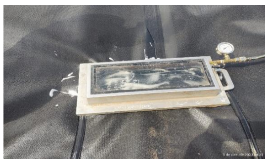
Figura 11: Ensaio de vácuo no reparo
