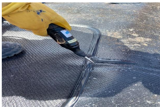
Figura 15: Spark test em reparos
