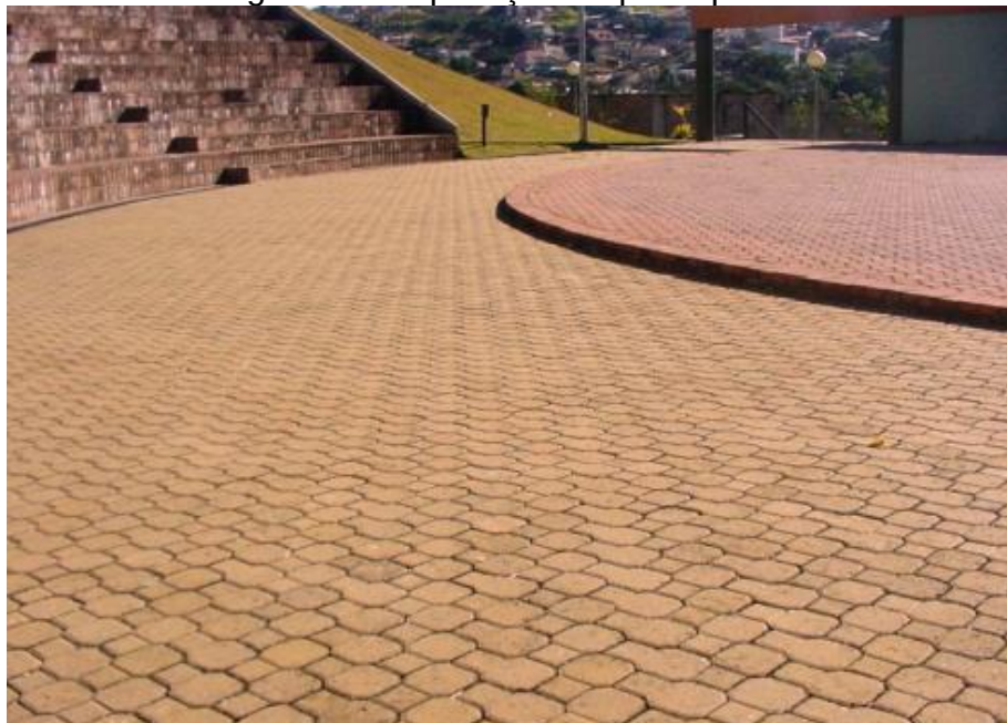
Figura 12 – Aplicação de piso tipo IV.
