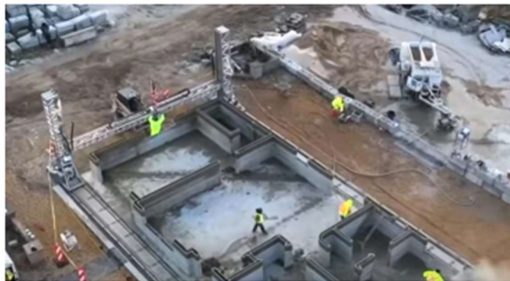
Figura 4 —Impressão 3D em execução nos Estados Unidos.
