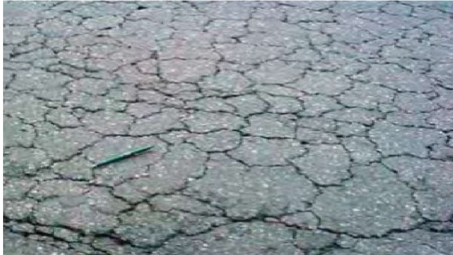
Figura 8 - Trinca tipo Couro de Jacaré. Fonte: (Bernucci, 2008).
