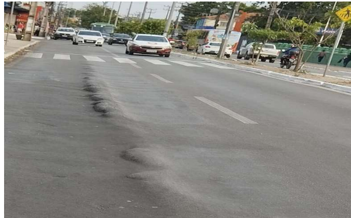
Figura 4 – Afundamento plástico nas trilhas de roda.
