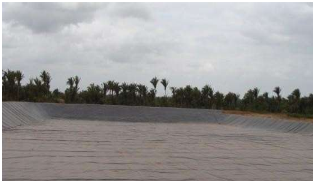
Figura 1: CGA TITARA – Impermeabilização de Fundo
