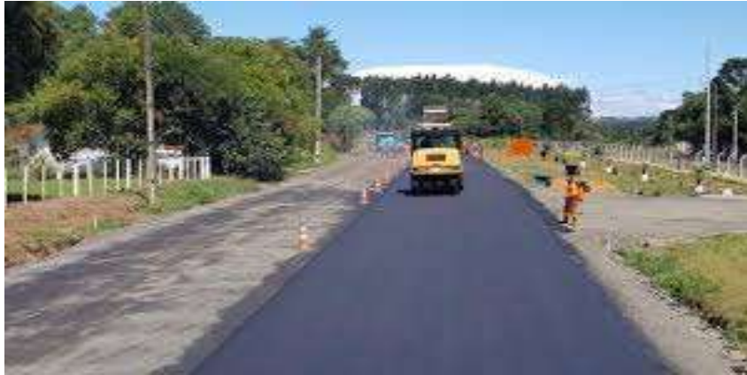
Figura 04 – Canteiro de longos
