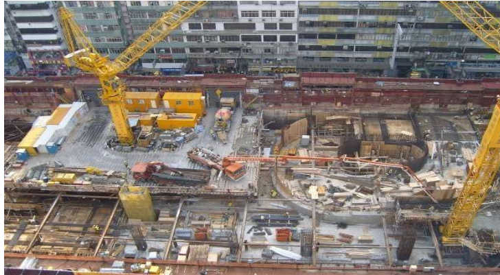
Figura 02 – Obra do tipo restrito
